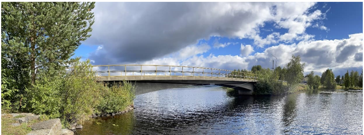
Figur 4. Befintlig bro över Viskasundet.
