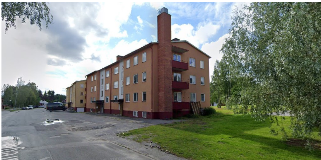
Foto på flerbostadshuset på fastigheten Boken 2.
